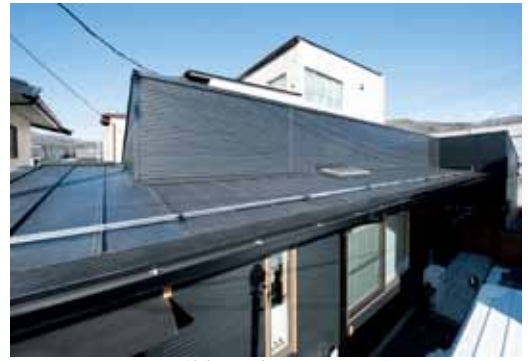
▲効率よく空気が暖めるように考えられた屋根。この壁の中を蛇行して空気が暖められる。
